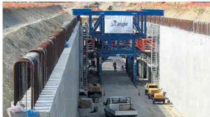
Il cantiere della galleria artificiale di Pozzolo
