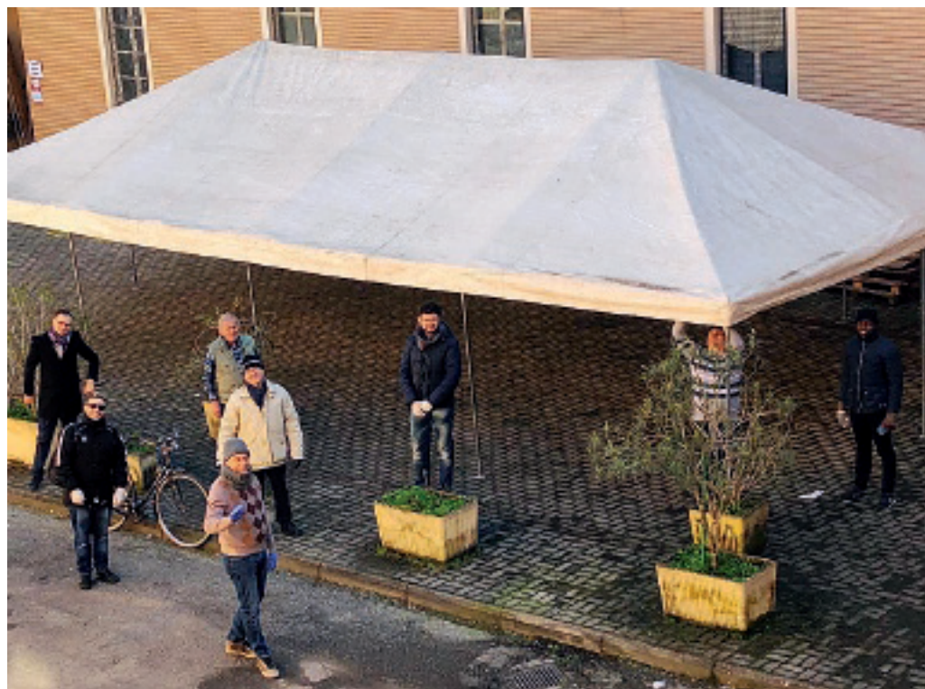
LA SOLUZIONE Il montaggio della tensostruttura provvisoria per la mensa solidale
