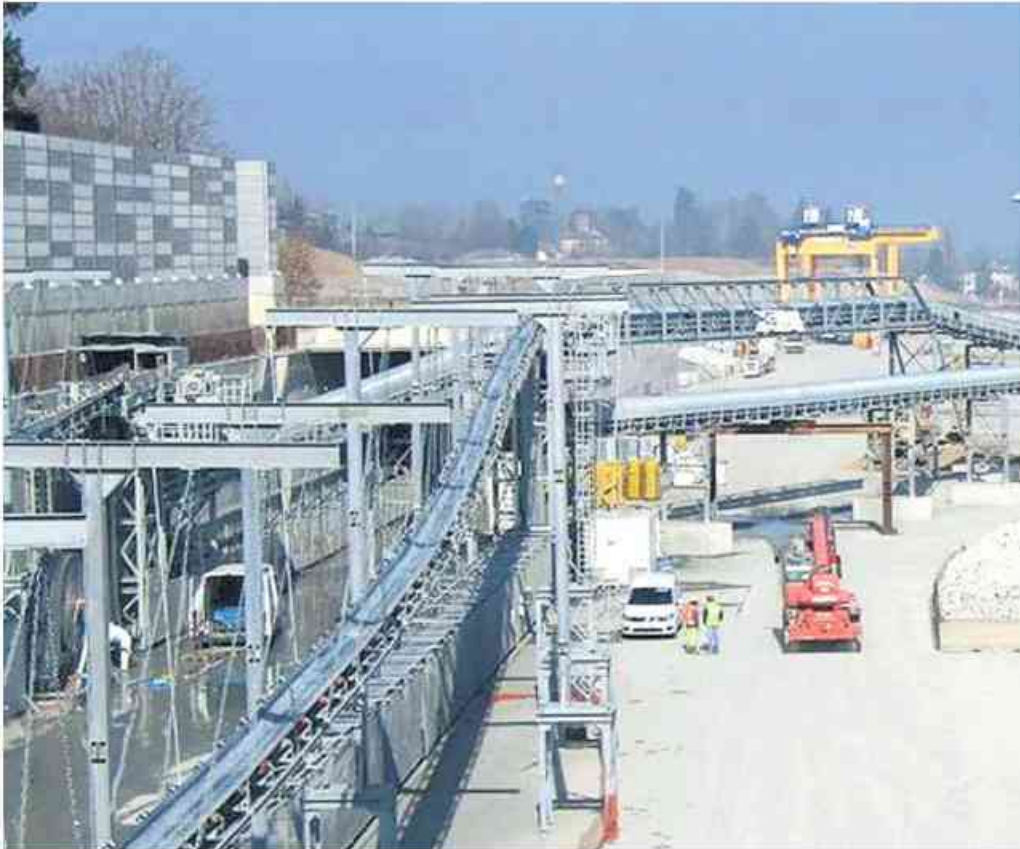
Il cantiere Basso Pieve del Terzo valico: la galleria verso Serravalle è lunga 4,2 chilometri
