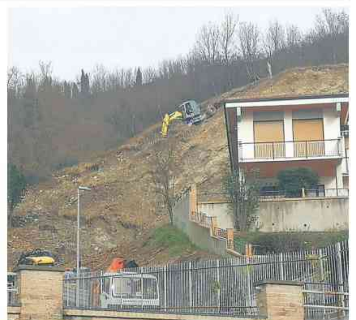
I lavori in corso sul versante del forte
