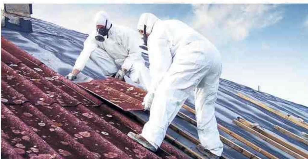
Rimozione di coperture di amianto: soprattutto nel Casalese la bonifica è incentivata
