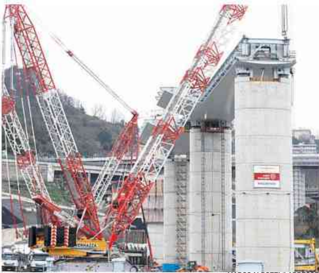
I lavori di costruzione del nuovo ponte sul Polcevera
