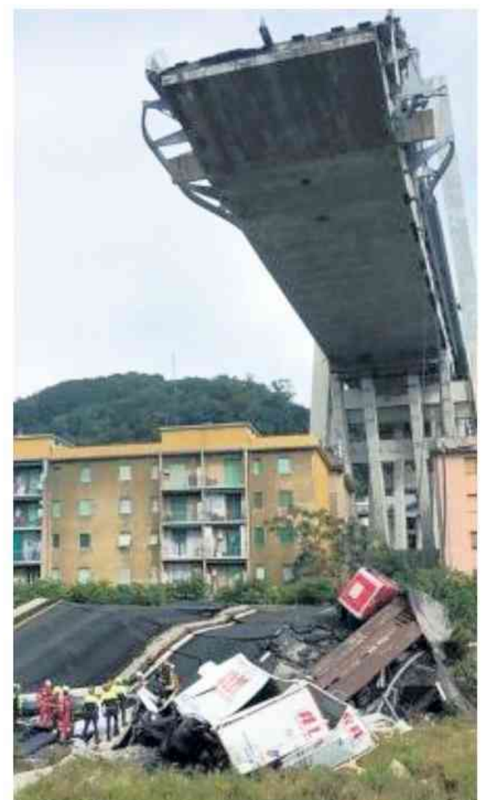
Il camion rosso della Mcm precipitato nel crollo del ponte Morandi
