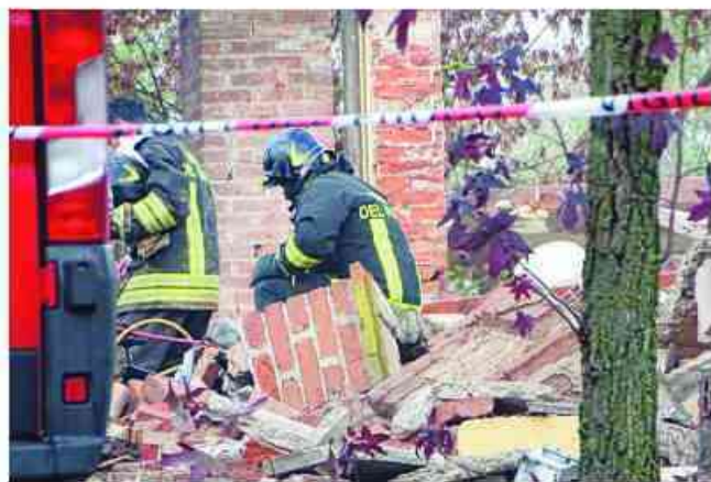
Le macerie della casa di Quargnento dopo l'esplosione mortale
