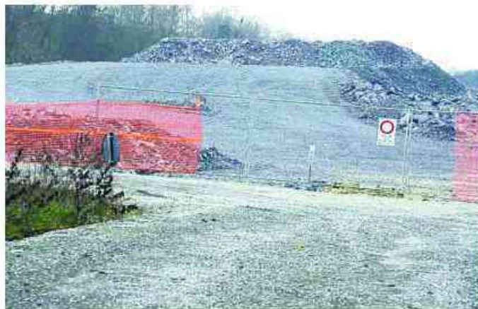
La cava in cui viene ammassato lo smarino del Terzo valico
