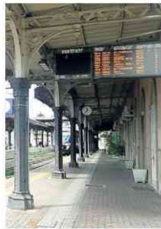
La stazione di Acqui Terme
