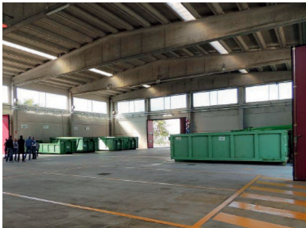
IMPIANTI IN FUNZIONE Il centro di raccolta dei rifiuti a Gestione Ambiente
