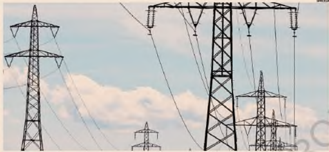
Distribuzione elettrica. L'aumento di tre punti percentuali dei concessionari dello Stato preoccupa il settore
