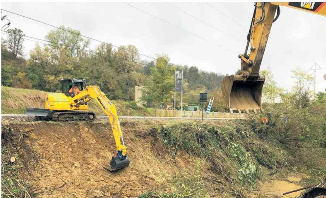
Lavori di ripristino della linea Ovada-Genova dopo le piogge di ottobre
