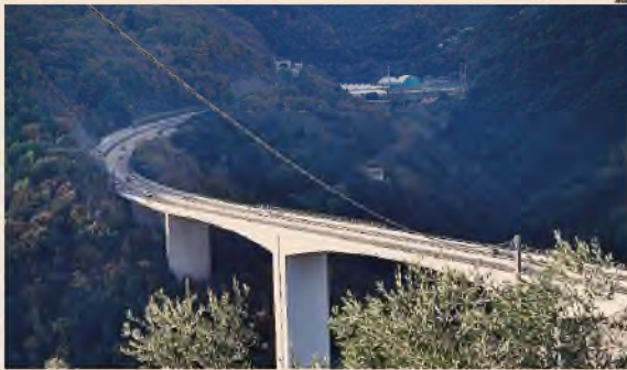
Inchiesta sui lavori di manutenzione. Il viadotto Sorf sulla A12, uno dei tratti sorvegliati speciali dalla Procura di Genova
