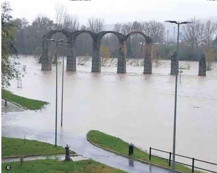
1. Il ponte Bormida ad Alessandria 2. Una sezione del viadotto Gorsexio sulla A26 3. Il sottopasso allagato nella frazione Astuti di Alessandria 4. I lavori per la messa in sicurezza del viadotto vicino a Mirabello 5. Le pompe dello scolmatore sul rio Loreto ad Alessandria 6. Gli archi romani di Acqui minacciati dalla piena
