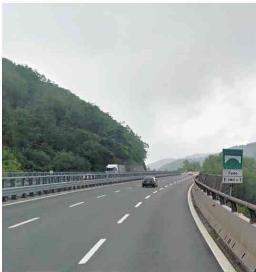
Il viadotto Fado lungo l'autostrada A26, in direzione Genova
