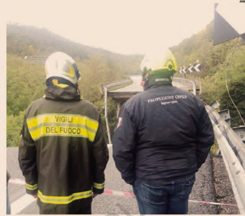
Il viadotto dell'A6 crollato. L'Autostrada dei Fiori (gruppo Sias) ha rilevato l'infrastruttura nel 2012
