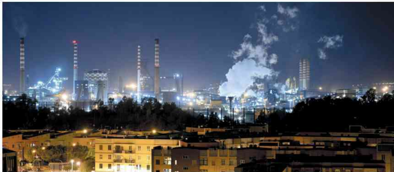
A Taranto operai e fornitori ArcelorMittal aspettano di conoscere l'esito della trattativa tra il governo e i vertici della multinazionale
