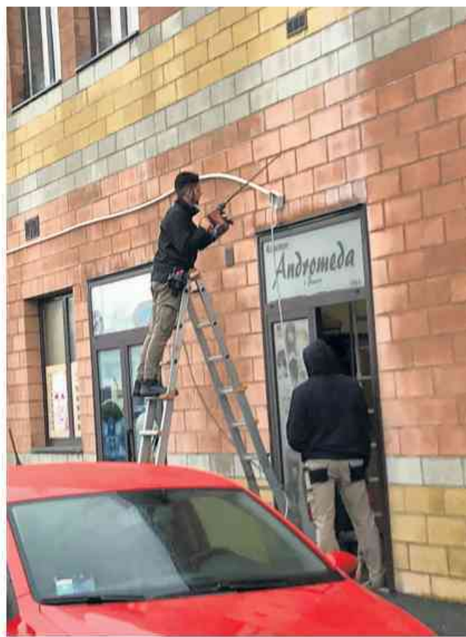
Gli elettricisti al lavoro per staccare la corrente elettrica
