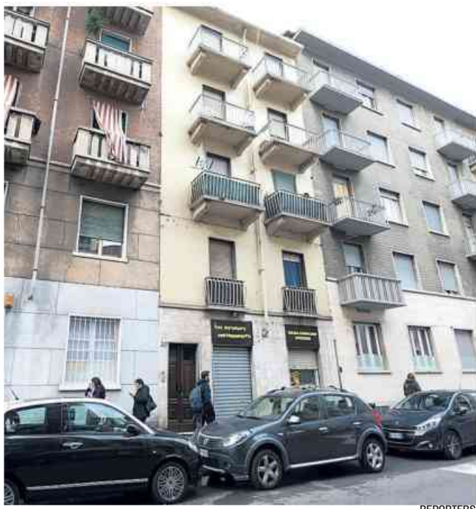
Lo stabile di Torino dove alloggiavano i clandestini
