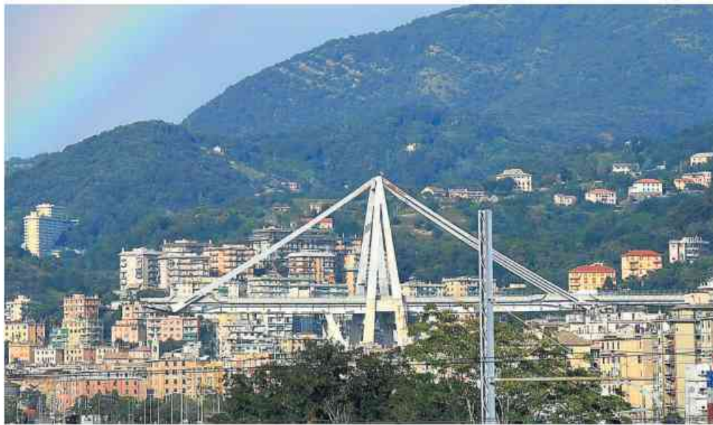
Il crollo del ponte Morandi, il 14 agosto 2018, ha provocato 43 morti
