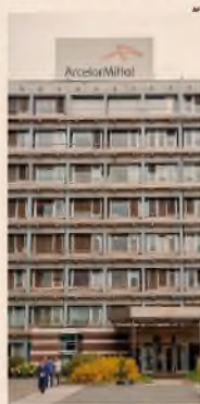
A Gand. La sede di ArcelorMittal
