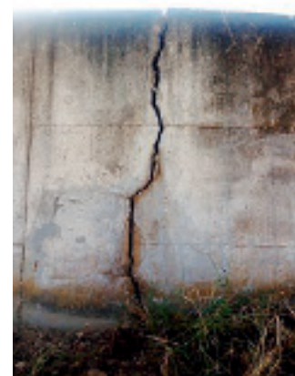
Il manufatto poi demolito
