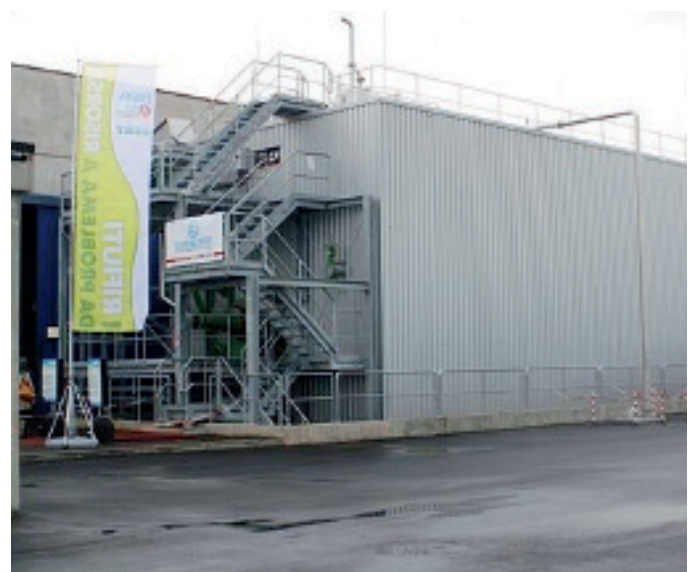
L'impianto biodigestore della Ecoprogetto
