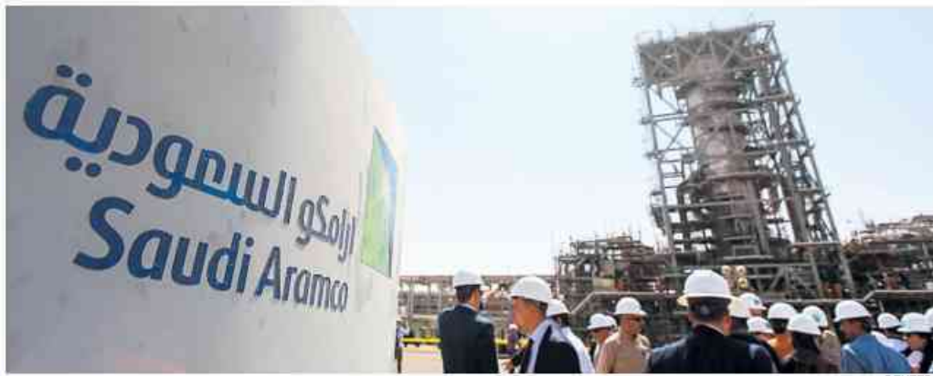
Un impianto della Saudi Aramco
