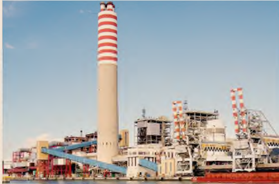
Lo stabilimento di Monfalcone. Investimento da quasi 500 milioni per la decarbonizzazione
