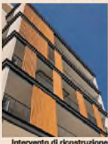
Intervento di ricostruzione
