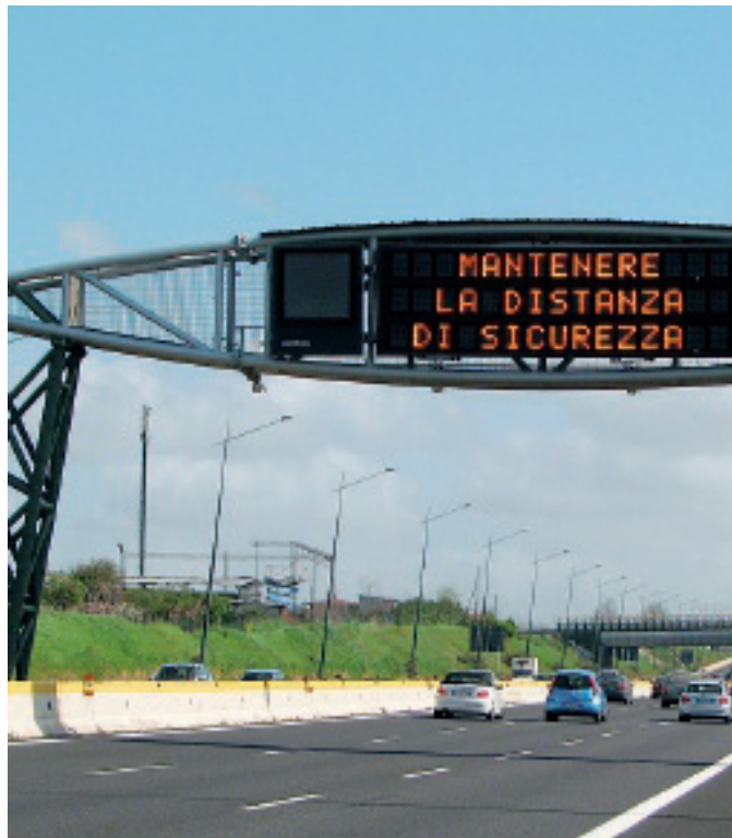
Il Gruppo Gavio potenzia l'impegno nel settore autostrade
