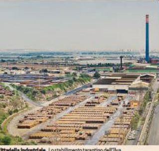
Cittadella Industriale. Lo stabilimento tarantino dell'Ilva
