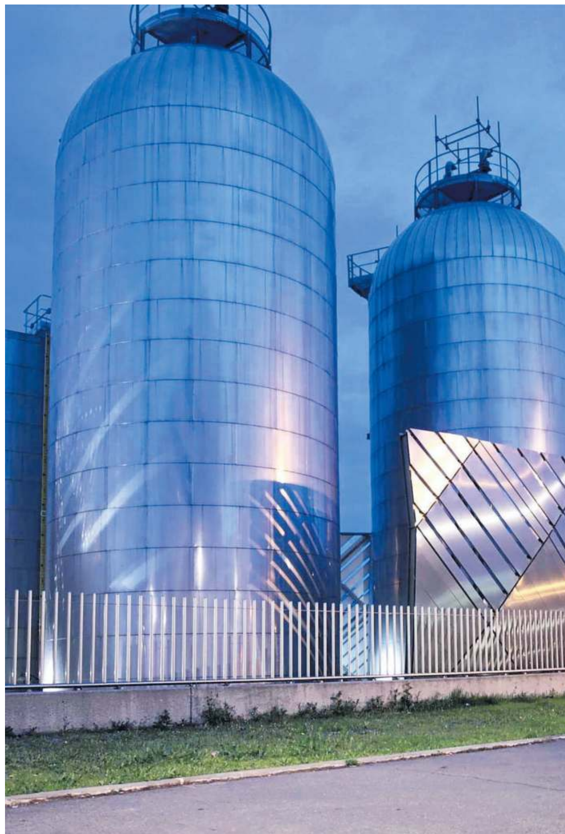
L'impianto di integrazione e riserva Politecnico, alimentato a gas naturale, dispone di 3 generatori di vapore a tu...
