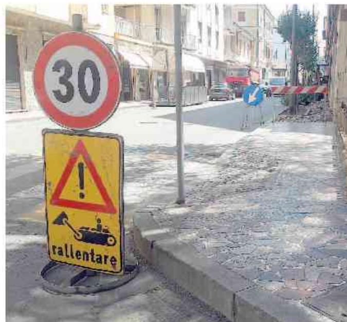
L'avvio dei lavori in via Torino a Ovada
