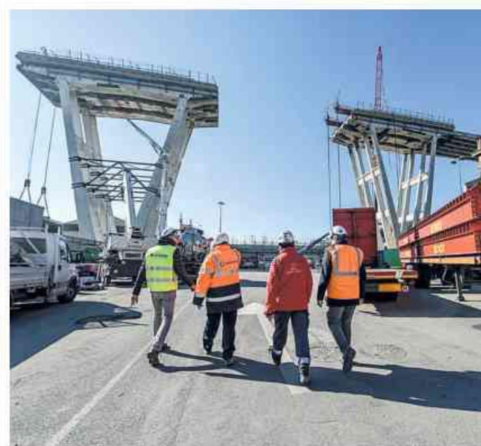
Lavoratori impegnati nella demolizione del Ponte Morandi
