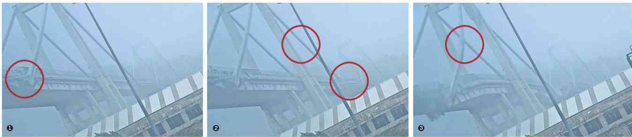
In sequenza le immagini acquisite dalla Finanza il 15 agosto 2018. Il video, secretato fino a ieri, mostra il crollo del Ponte Morandi del 14 agosto 2018 (43 vittime). 1. Alle 11.36 un camion si appresta a superare il pilone. 2. La rottura di un tirante (cerchio in alto) provoca il primo cedimento della strada (cerchio in basso). 3. Si innesca una reazione a catena: si rompe anche il tirante opposto (cerchio) e crolla tutto
