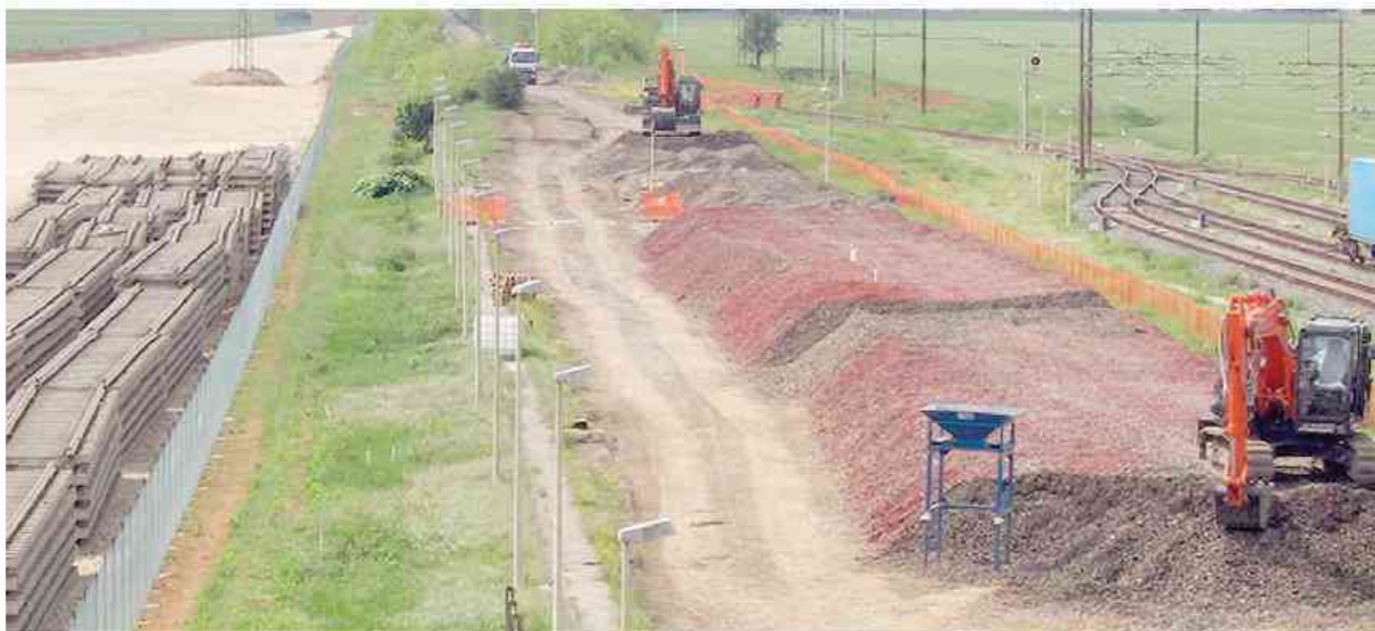
I lavori sulla linea Novi-Pozzolo-Tortona
